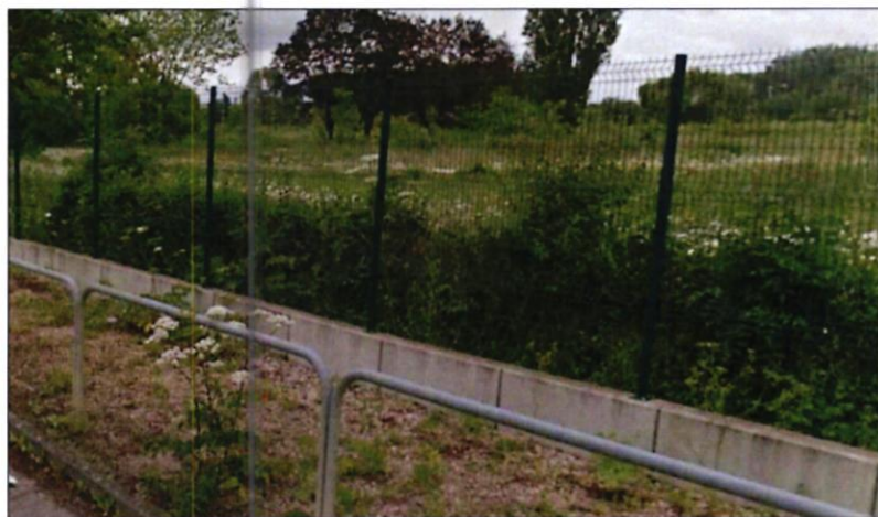
Clôture existante conservée et complétée (soubassement en béton; poteaux en acier galvanisé plastifiés de couleur vert mousse (RAL 6005); un grillage maillé 200/55mm en acier galvanisé de couleur vert mousse (RAL 6005) hauteur 2m.
